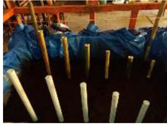
Gambar 2. Tiang bambu dan beton yang dipancang ke dalam tanah gambut
